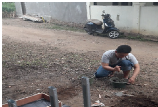
Gambar 6 Pembuatan Pengecoran Tempat Sampah
